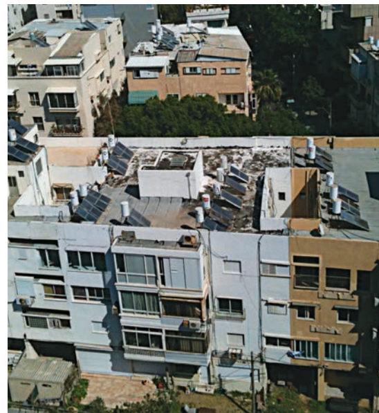
■ Una copertura di un edificio costellata di pannelli solari termici e relativi serbatoi
