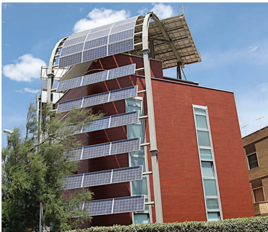
■ Efficienza energetica, sostenibilità e integrazione funzionale dei dispositivi di produzione energetica costituiscono la strada necessaria del progetto e della costruzione cui tutto il settore, committenti, progettisti e imprese, deve rispondere con sempre maggiore competitività
