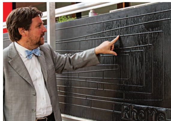
■ L'effetto di condensa sulla superficie del pannello, quando è in funzione durante la stagione calda
