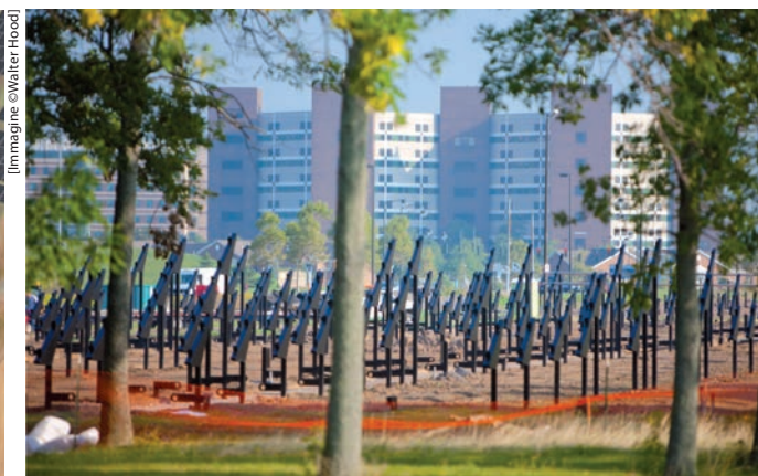
■ Solar strand/Campus dell'Università di Buffalo (Buffalo - USA 2011) - Progetto Hood Design. L'impianto, costituito da 5.000 moduli fotovoltaici standard, è stato disegnato ispirandosi alla struttura della molecola di DNA, in modo che la forma non fosse monotona e ripetitiva, ma ogni singola fila di moduli fosse riconoscibile, costituendo un elemento di orientamento per gli utenti. Il sistema fotovoltaico, che copre buona parte dell'impronta energetica del campus, non è visto come un impianto poggiato sul terreno, ma come una parte del paesaggio, ibrido, che mette insieme il luogo che le persone vivono, ed il luogo in cui l'energia necessaria al funzionamento del campus viene generata. Non si tratta della rinuncia ad un tentativo di integrazione del fotovoltaico negli elementi costruiti, quanto della affermazione della dignità del fotovoltaico di essere guardato come nuovo elemento del paesaggio per la sua capacità di generare energia
