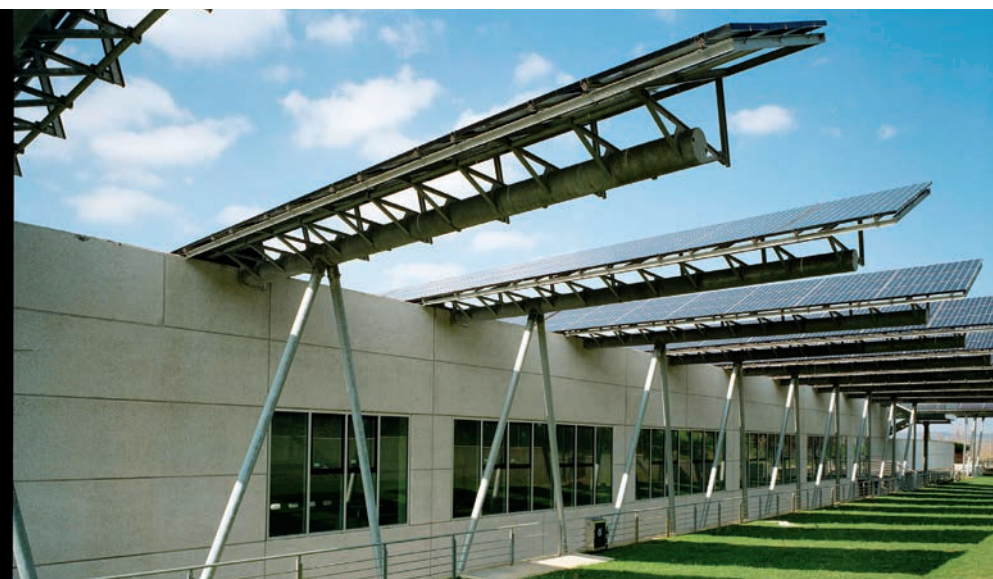
■ Nuova sede dello stabilimento Rainbow (Ancona - Italia 2011) - Progetto Sergio Bianchi, Elisabetta Straffi. La nuova sede della Rainbow è un edificio a consumo energetico quasi zero, ed affida il suo funzionamento ad un impianto geotermico abbinato al fotovoltaico, oltre che ad un attento uso del daylight . La sua impronta energetica non è contenuta entro l'impronta fisica, ed infatti il fotovoltaico «sporge» dalla copertura a conformare delle estensioni, che disegnano una sorta di brise-soleil . Qual è la natura dello spazio conformato dal brise-soleil ? Appartiene all'edificio o all'esterno?
