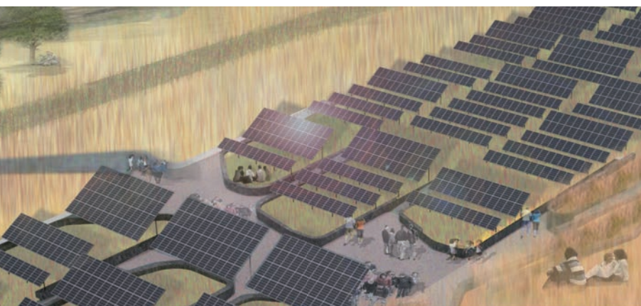
■ Solar strand/Campus dell'Università di Buffalo (Buffalo - USA 2011) - Progetto Hood Design. L'impianto, costituito da 5.000 moduli fotovoltaici standard, è stato disegnato ispirandosi alla struttura della molecola di DNA, in modo che la forma non fosse monotona e ripetitiva, ma ogni singola fila di moduli fosse riconoscibile, costituendo un elemento di orientamento per gli utenti. Il sistema fotovoltaico, che copre buona parte dell'impronta energetica del campus, non è visto come un impianto poggiato sul terreno, ma come una parte del paesaggio, ibrido, che mette insieme il luogo che le persone vivono, ed il luogo in cui l'energia necessaria al funzionamento del campus viene generata. Non si tratta della rinuncia ad un tentativo di integrazione del fotovoltaico negli elementi costruiti, quanto della affermazione della dignità del fotovoltaico di essere guardato come nuovo elemento del paesaggio per la sua capacità di generare energia
