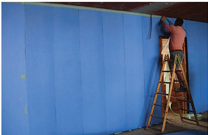
■ Posa in opera dell'isolante acustico per pareti: una corretta posa dell'isolante dovrà essere preceduta da un'attenta realizzazione delle pareti in laterizio e da una corretta posa della malta. Il doppio intonaco (rinzafo) sulla prima parete consente di migliorare le prestazioni acustiche
