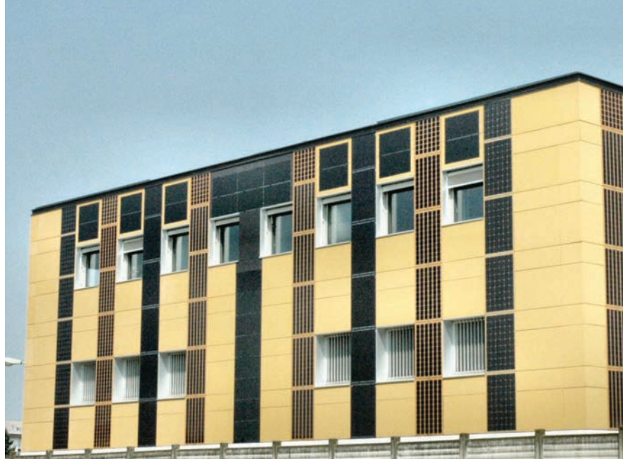
■ Le pareti sud ed est dell'edificio sede di Aderma Locatelli Group, mostra l'involucro ad alta efficienza energetica completato: la fase successiva, ancora in corso, è quella di calibrare il sistema di monitoraggio e la strutturazione dei dati di rilievo. Il prelievo dell'energia elettrica prodotta dai pannelli fotovoltaici ed il relativo monitoraggio è già in atto
