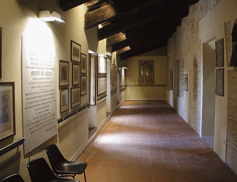
■ A sinistra in basso, lungo il muro perimetrale, si può notare l'installazione del battiscopa radiante «Best Board» per il riscaldamento di una struttura museale
