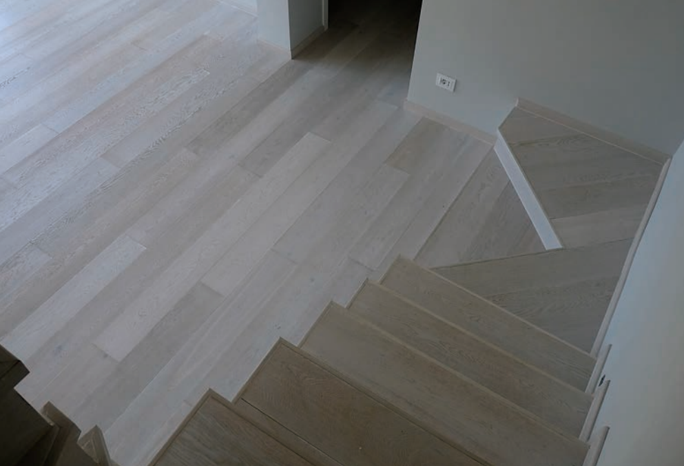
■ Realizzazione di Vear Parquets di una scala angolare e pavimento con Tavole del Brembo in plance di Rovere «Country White» spazzolato e rifinito con vernici eco-compatibili
