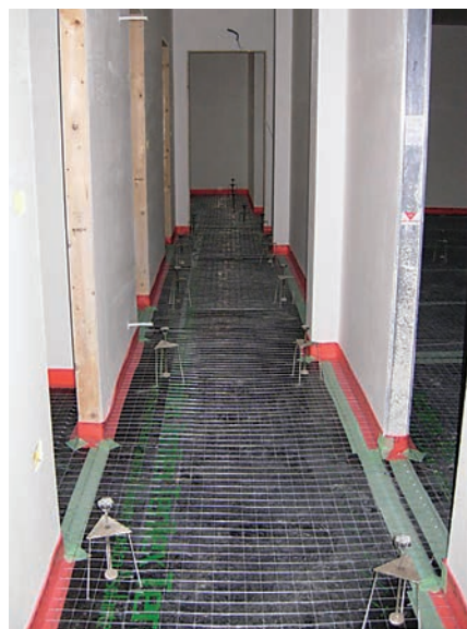
■ Isolamento acustico al calpestio: corretta preparazione del «pavimento galleggiante» prima del getto del massetto
