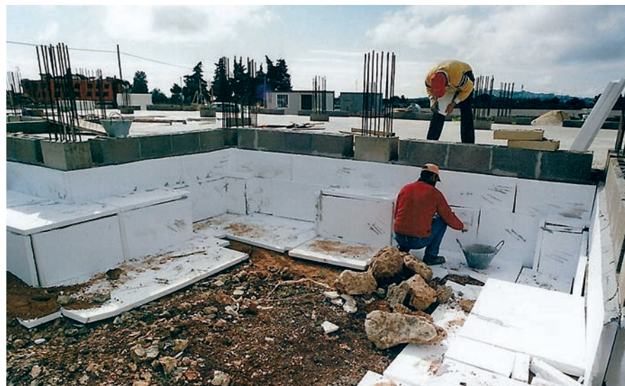
■ Foto 5. L'isolamento perimetrale, realizzato al contorno delle fondazioni, con una fascia di cm 5 di polistirene espanso estruso estesa fino ad uno sviluppo di 3 metri dal piano di campagna, ed un accurato drenaggio del terreno circostante, per diminuirne la conduttività
