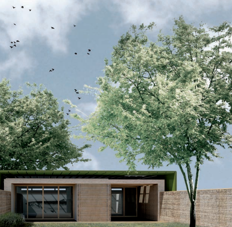
■ Visione della casa mediterranea sostenibile «Med in Italy» dal patio interno. Le logge protette da brise soleil in vimini, funzionano da buffer zone mitigando il passaggio di calore tra interno ed esterno. L'opera artistica alla parete è di Massimo Catalani. [immagine: Converso]
