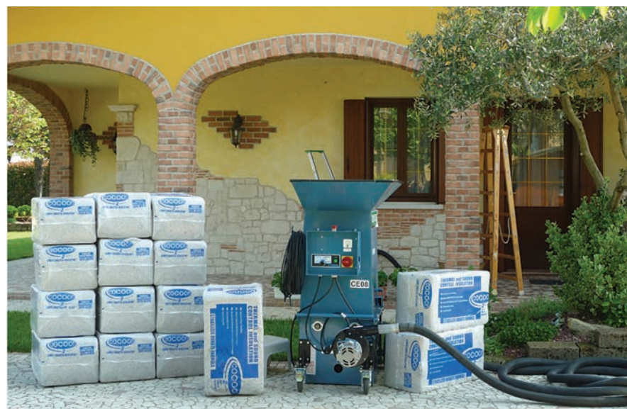
■ Cellulosa stabilizzata «Bonded Green Fiber» e apposita attrezzatura per insufflare il prodotto nei muri perimetrali in mattoni oppure in cemento armato con intercapedine
