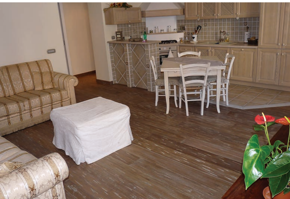
■ Il pavimento, posato da Vear Parquets sopra un impianto di riscaldamento a pavimento, è stato realizzato con Tavole del Brembo in plance di Rovere «Modern Gray» piallate a mano e rifinite con vernici eco-compatibili
