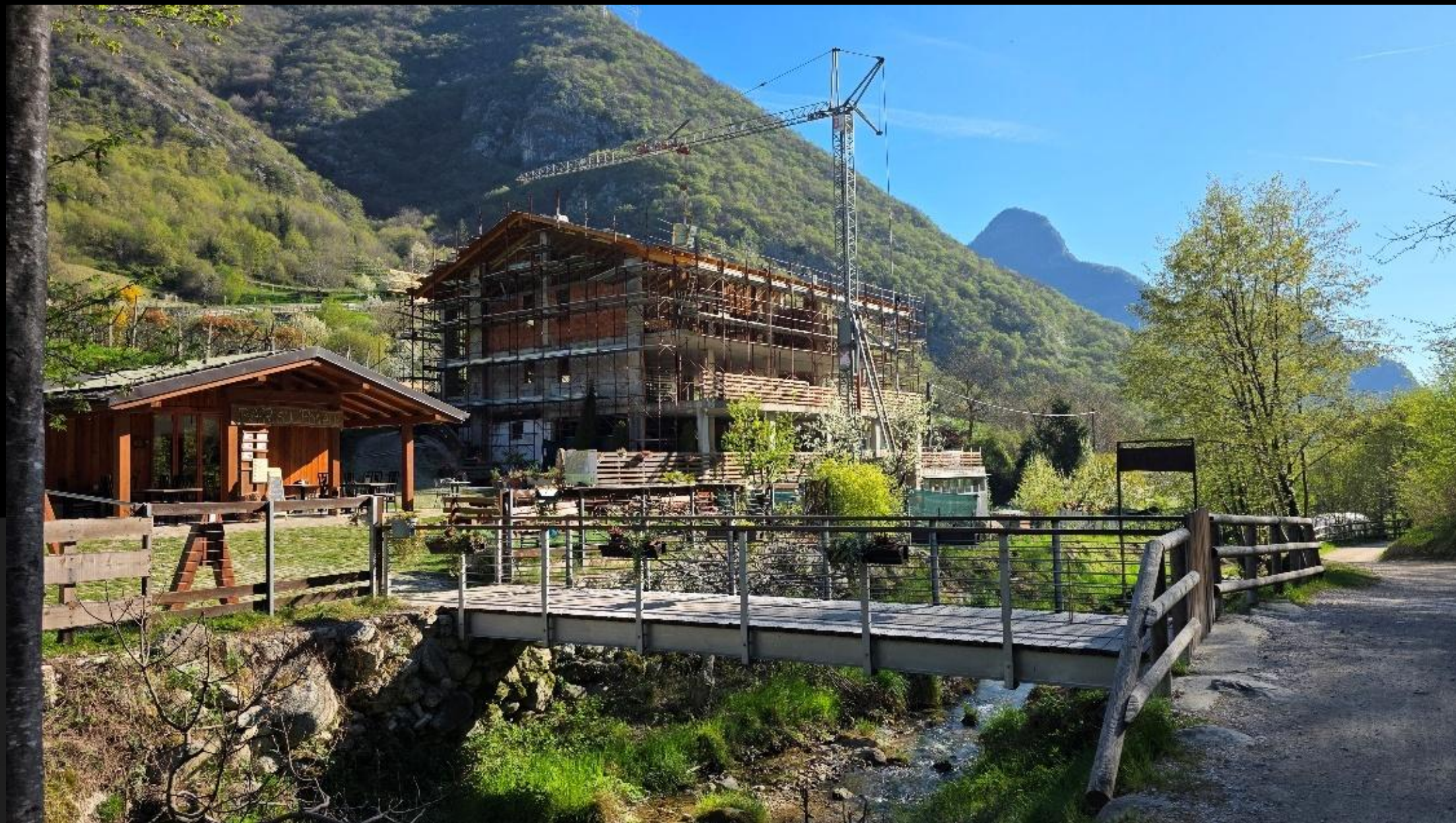
Edificio in costruzione lungo il sentiero del Ponale (Ledro, TN)
