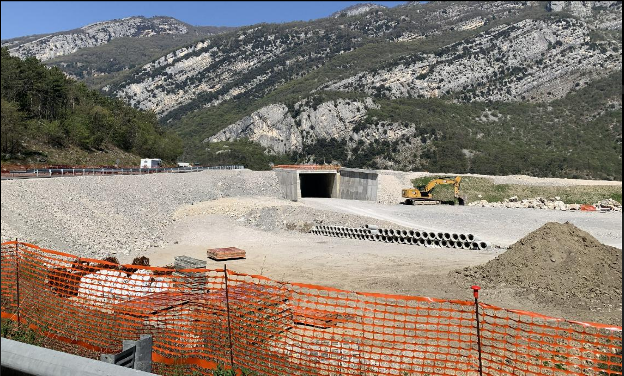
Cantiere per la realizzazione della galleria Loppio-Busa che collegherà Vallagarina e l'Alto Garda
