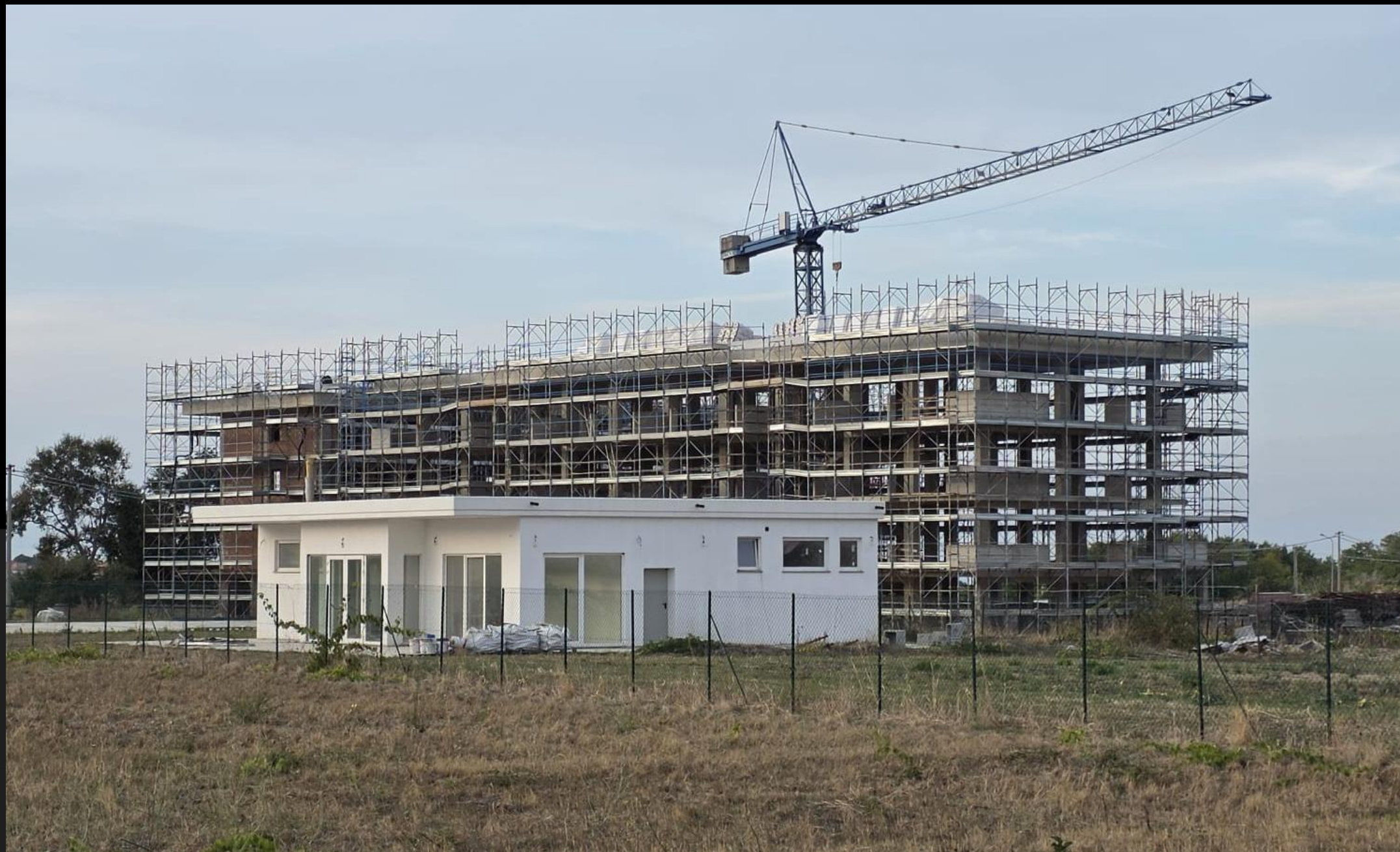
Edificio in costruzione Santa Maria Imbaro (CH), settembre 2026
